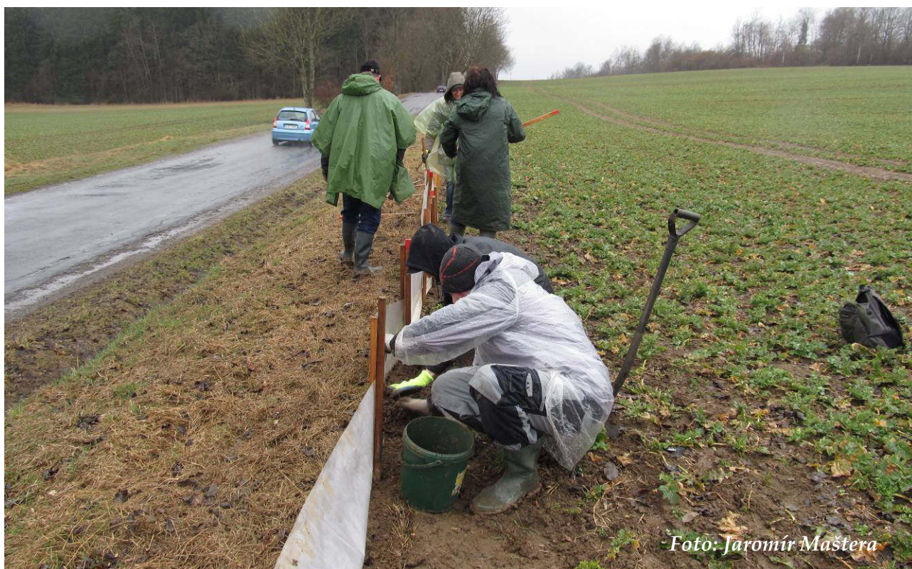
Foto 1: Budování zábran u Svitáku – zatlukání kůlů a upevňování folie (březen 2017)
