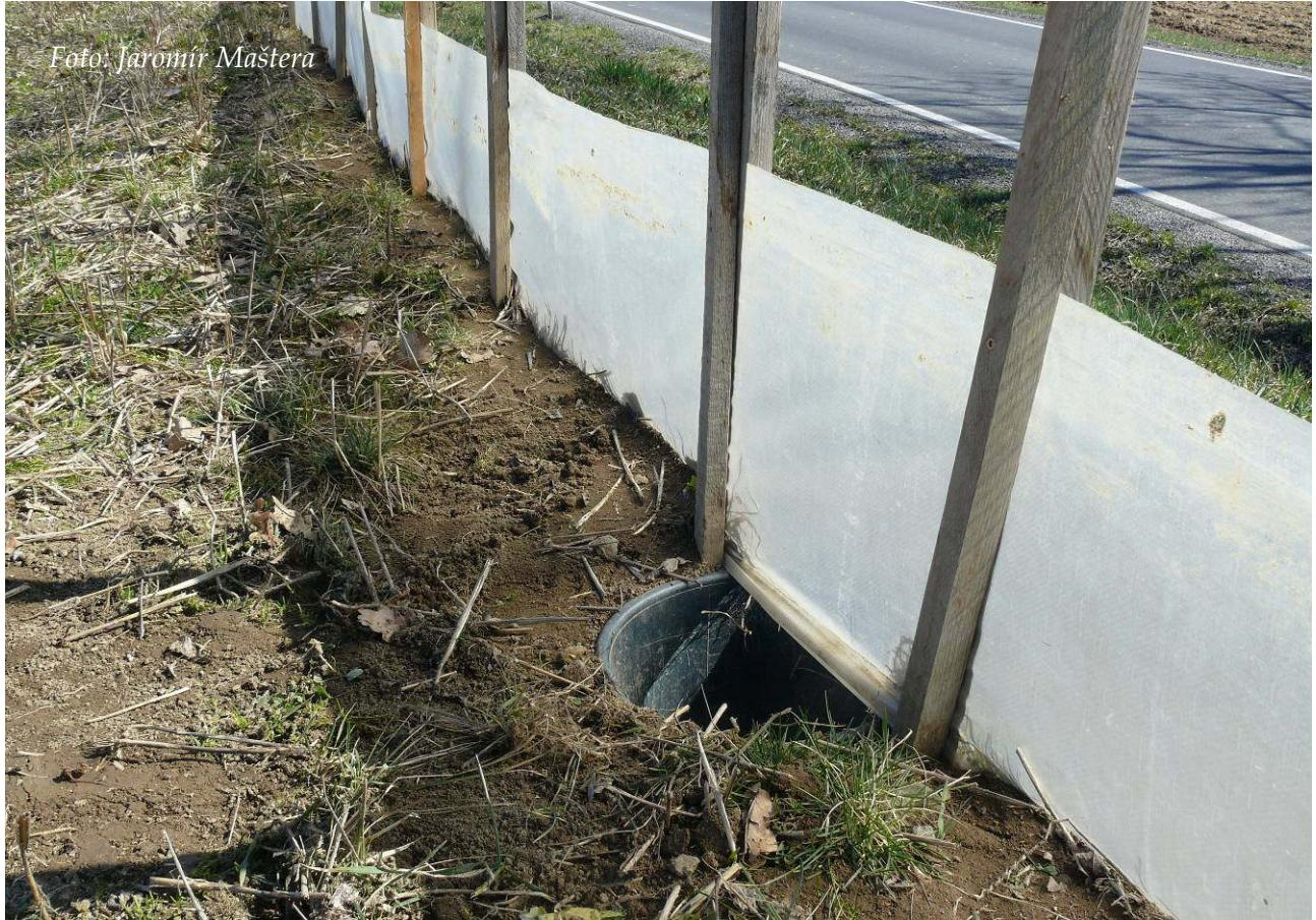
**Foto 3:** Instalované zábrany u Svitáku – detail s odchytovou nádobou (březen 2019)
