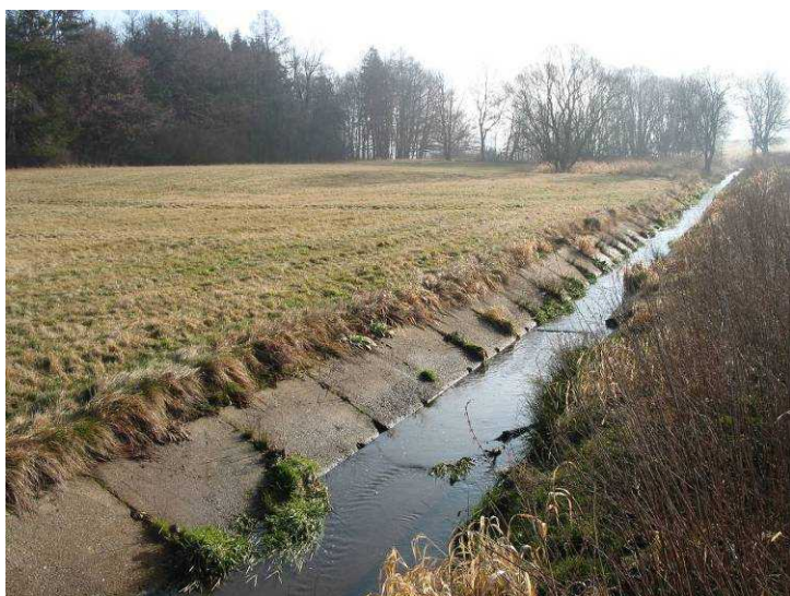
Obr. 2 Vodní tok degradovaný technickou úpravou
