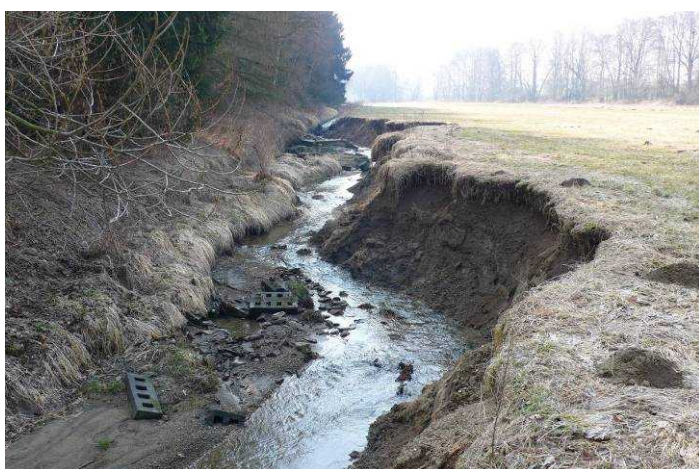
Obr.31 Rozpadem opevnění a vymíláním havarovala „meliorační“ úprava potoka. Obnovuje se členitost koryta, to však je ještě více zahloubené než dřívější technická úprava, je nestabilní a zbytečně odvodňuje přiléhající nivu. Nejlepším řešením, pokud to bude pozemkově průchodné, tu bude vybudování nového, přírodě blízkého koryta v „rostlém“ terénu nivy a bezpečné zasypaní koryta dosavadního.
