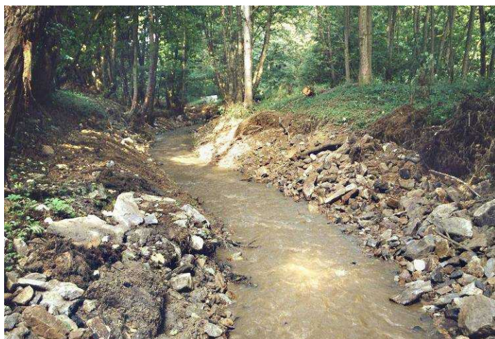
Obr. 37 Zbytečná, devastující prohrábka lesního potoka po povodni. Členité tvary koryta, zanechané povodní, zde ničemu nevadily. Koryto je po zásahu hlubší a méně členité než dříve – a rychleji povede další povodeň. Stopy zbytečného škodícího zásahu přestanou být během několika let zřetelné, na náhradu zničených kořenových systémů stromů však bude nutné čekat podstatně déle.
