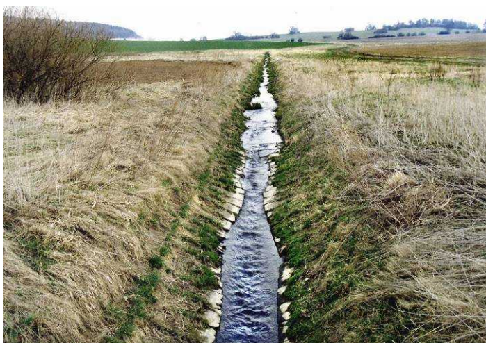
Obr. 32 V tomto úseku tvrdě technicky upraveného potoka by trvalo dlouho, než by samovolné renaturační procesy navodily přijatelný morfologický stav koryta – odolné opevnění, nadměrné zahloubení koryta, tvrdě geometrizovaná trasa. Tento úsek je vhodné hodnotit jako úsek vyžadující investiční revitalizaci.
