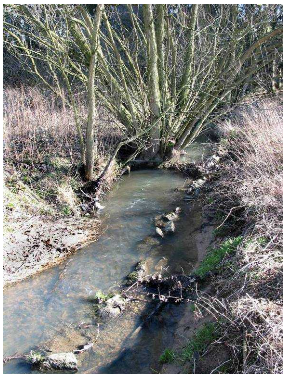
Obr. 25 Renaturace technicky upraveného koryta rozpadem opevnění. Jedná se o starší úpravu s opevněním kamennou dlažbou. Dlažba se rozpadá na jednotlivé kameny. Pozitivní úlohu sehrávají stromy, rostoucí v korytě, které rozvlňují proudnici, a tím podporují vymílání do stran. Nedochází k nadměrnému zahlubování koryta. Zde není třeba zasahovat.
