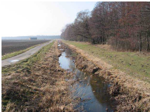
Obr. 17 Z Rámcové směrnice o vodní politice plyne, že by dalšími nevhodnými zásahy neměl být zhoršován ani stav vodních toků, které byly v minulosti postiženy úpravami. To je důležité zvláště u technicky upravených toků, jejichž stav se již poněkud zlepšil působením samovolných renaturačních procesů.
