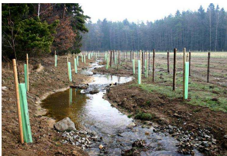
Obr. 3 Přírodě blízké koryto vodního toku, vytvořené při revitalizaci investičního charakteru
