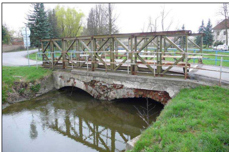
Obr. 22 Při zajišťování potřebné povodňové průtočnosti koryt je třeba vyhledávat a řešit nebezpečná místa, kterými bývají nevyhovující mosty, lávky a propustky nebo různé stavby, návážky a skládky, nevhodně umístěné v říčních územích.
