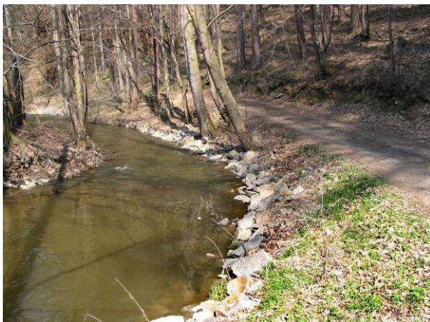
Obr. 18 V tomto místě ohrožovala říčka lesní cestu. Opevnění břehu tu je odůvodněným zásahem a bylo provedeno citlivým, nedevastujícím způsobem, kamenným záhozem.
