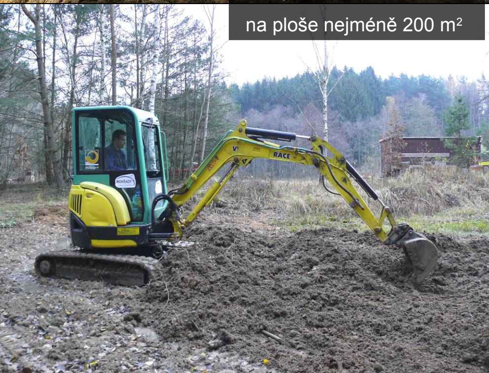
Stržení drnu v pískovně a prohloubení tůň:
