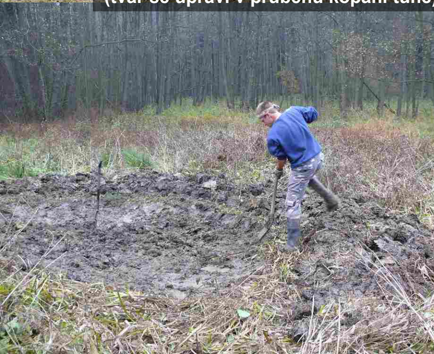
Přibližné vytyčení tůně (tvar se upraví v průběhu kopání tůně)
