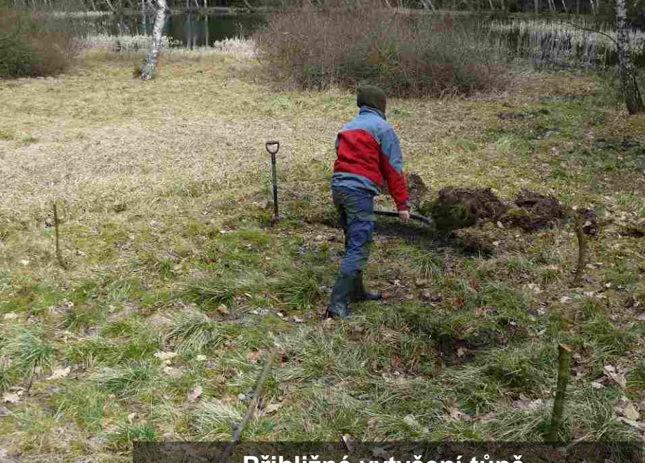
Přibližné vytyčení tůně (tvar se upraví v průběhu kopání tůně)
