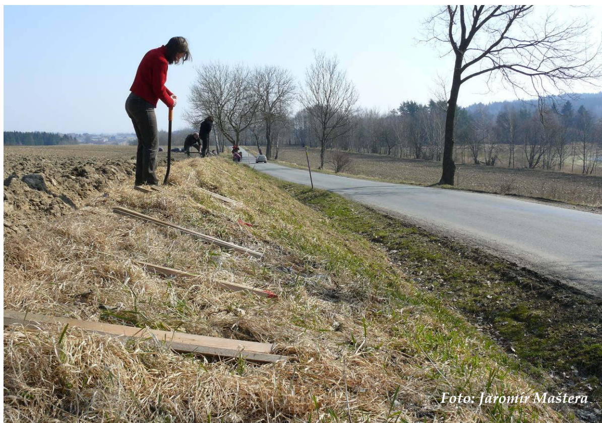
Foto 1: Začátek stavby zábran u Svitáku – tvorba drážky na zasunutí folie (březen 2015)
